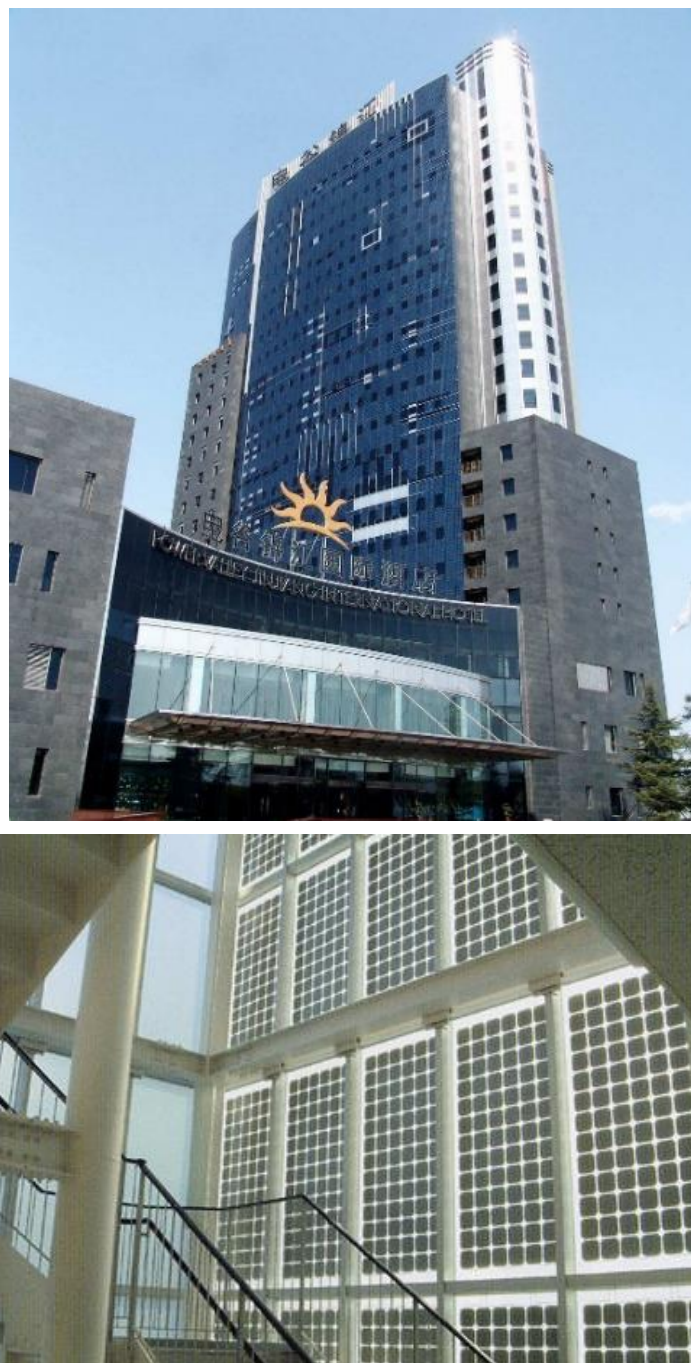
图5.11 光伏外墙与光伏幕墙
