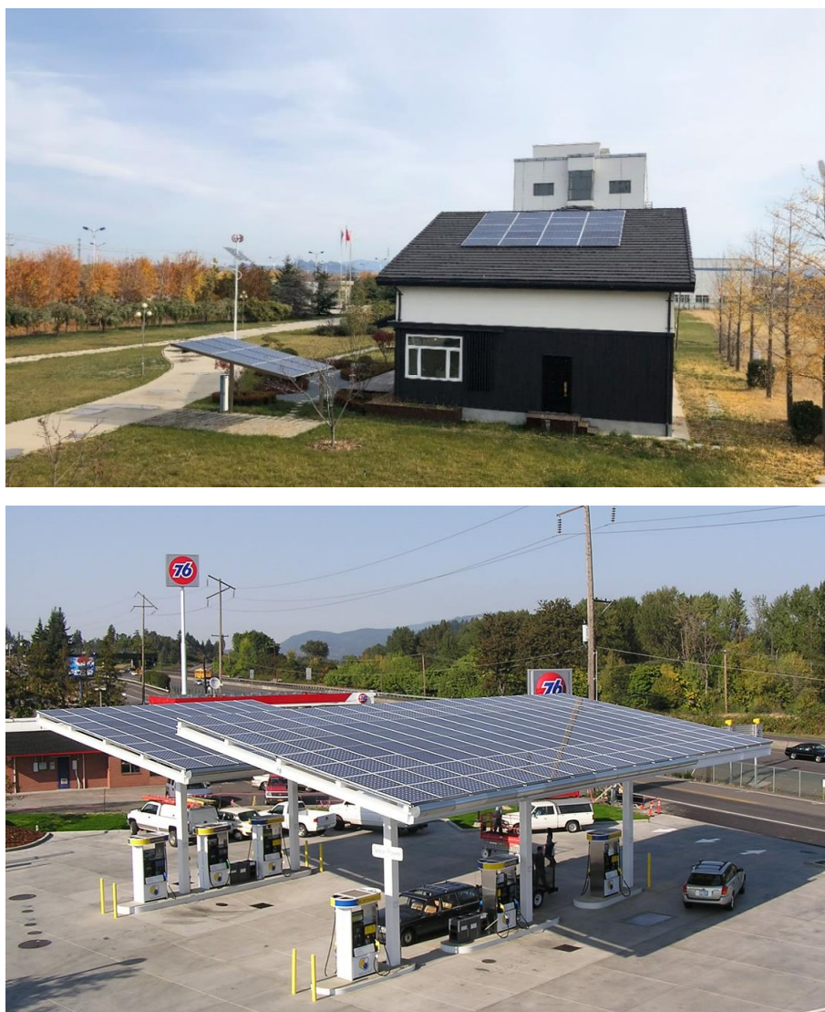
图5.12 光伏发电系统与停车棚结合实例
