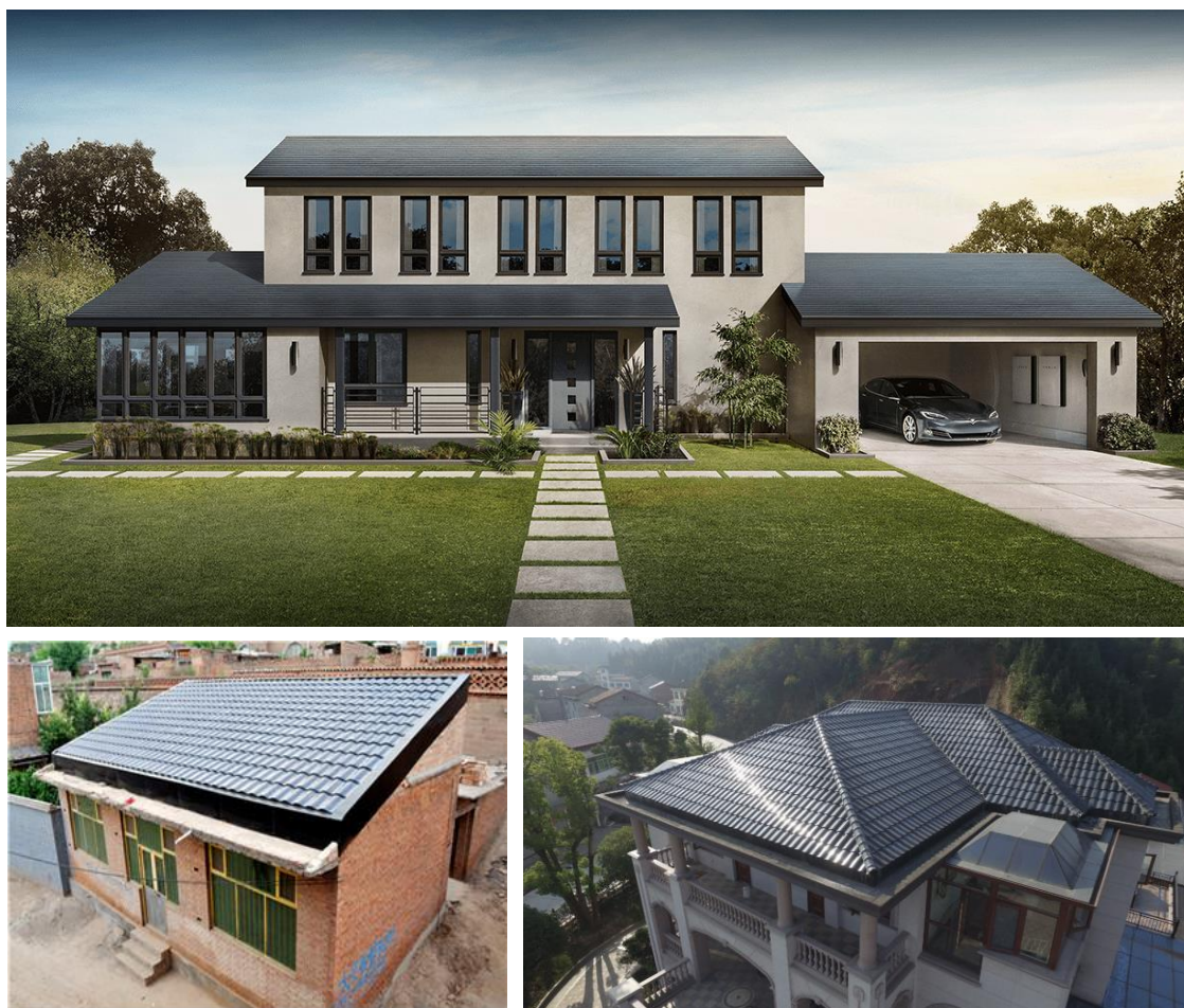
图5.10 光伏系统与建筑屋顶相结合的建筑实例
