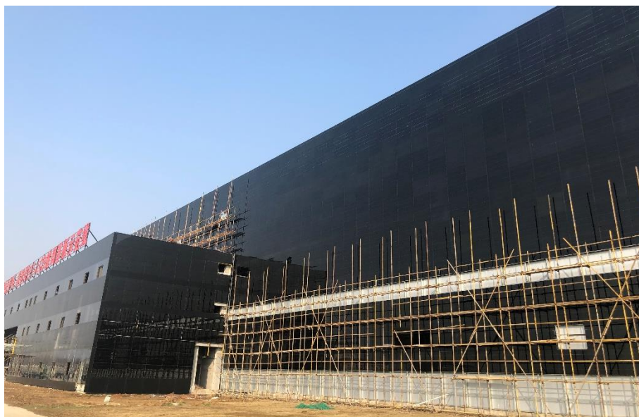
图5.8 蚌埠中建材玻璃生产车间外墙光伏发电系统
