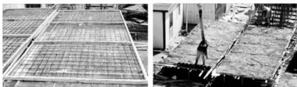
(a) 模板支护、钢筋绑扎 (b) 混凝土浇筑
