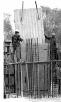
(c) 预制混凝土板吊装
