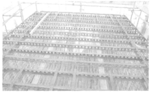
图 2 实际楼板型钢布置
