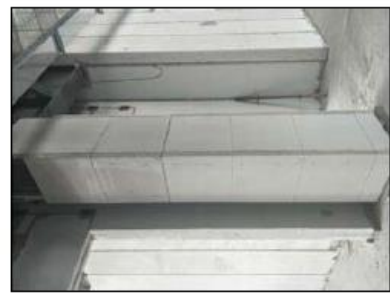
钢柱包防火板
