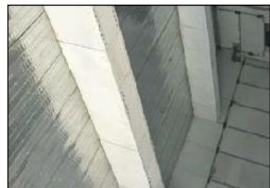
钢梁包防火板
