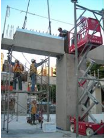
图 36 支撑架上部小型钢撑紧照片
