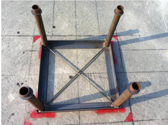
图 5 定位架组立角钢（蜡烛台）
