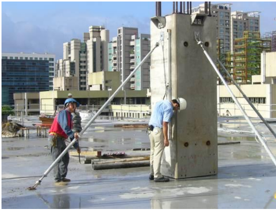
图 20 使用防风型垂直尺量测
