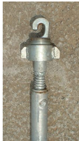
图 19 柱斜撑端部
