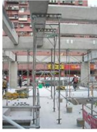
图 31 支撑架偏心施做照片
