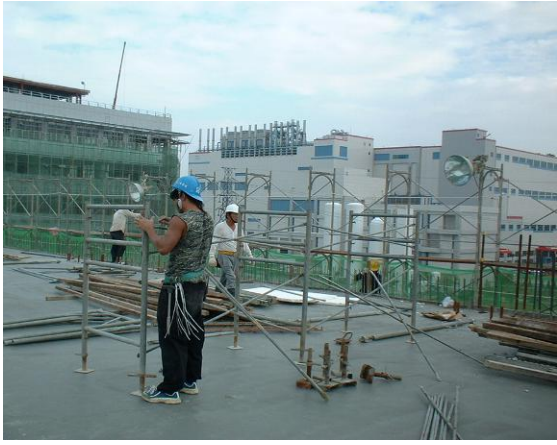
图 30 梁支撑架搭设照片
