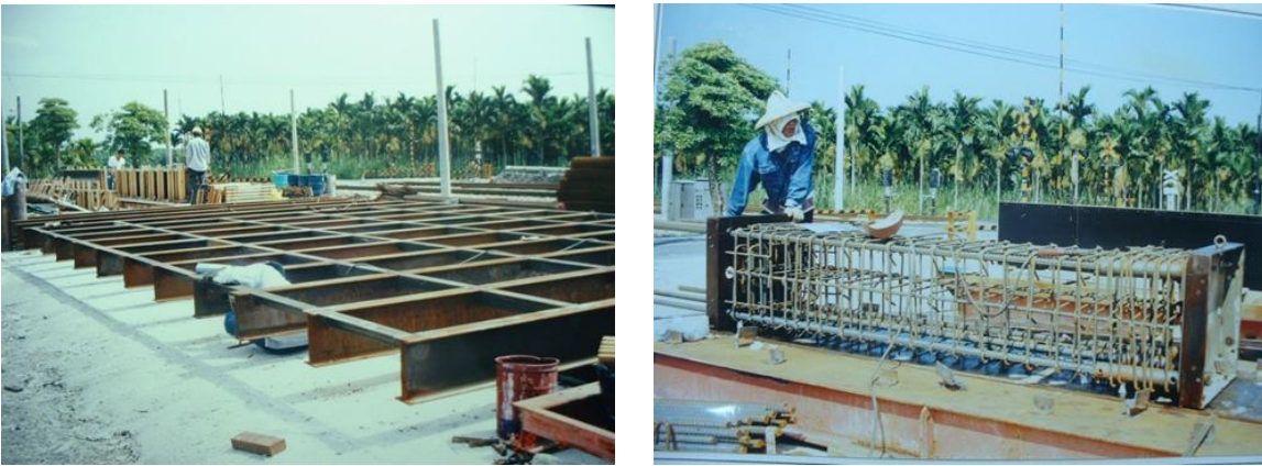
图 2 及图 3 1998 台湾地区花莲慈济精舍现场预制照片
