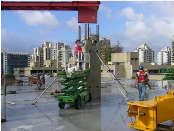
图 22 塔吊勾头松绑
