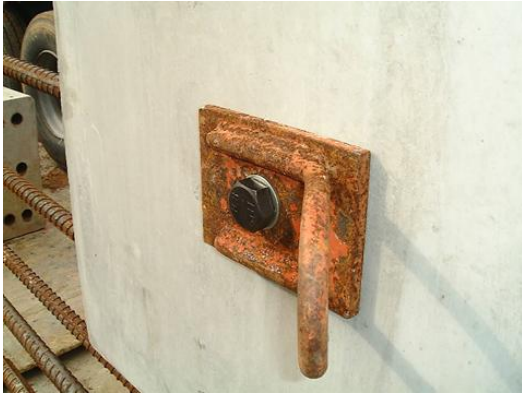
图 15 柱斜撑固定座
