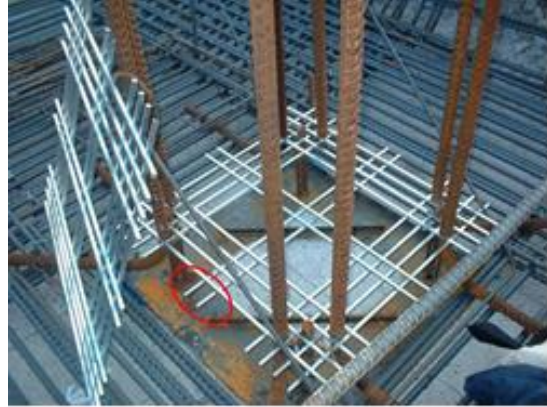
图 6 格网箍钢棒（烤肉架）
