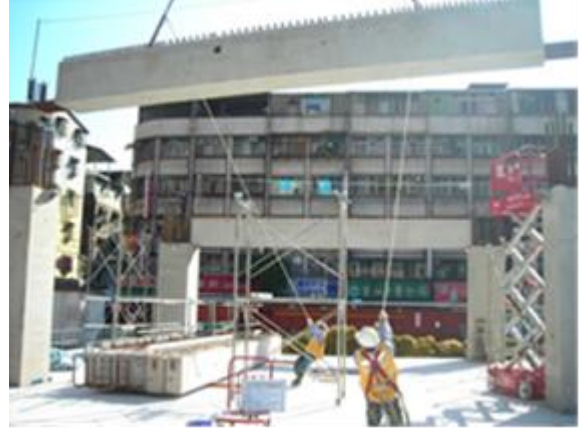
图 33 梁以牵引绳牵引方向
