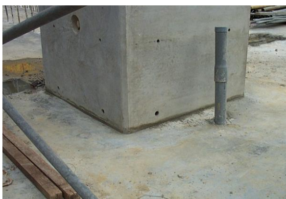
图 26 柱底高强砂浆封模
