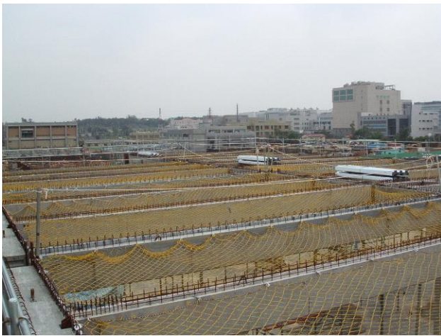
图 37 安全网施做完成照片
