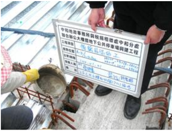
图 38 梁柱接头封模照片
