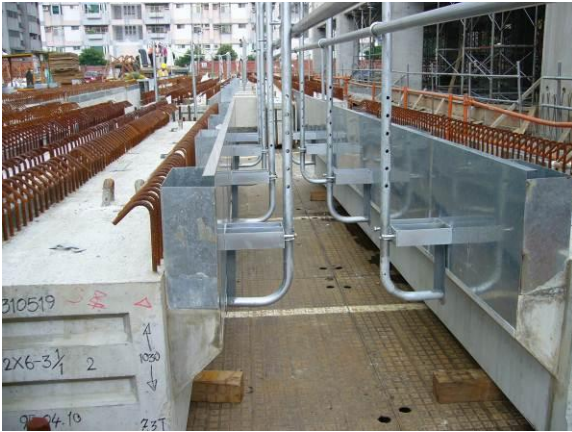
图 32 边梁安全栏杆地面先装好
