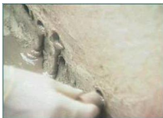
图 27 柱无收缩灌浆正确出浆照片
