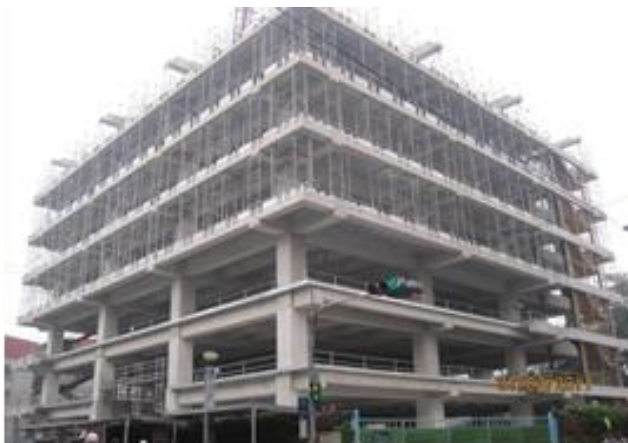
图 41 悬臂楼版的支撑架照片
