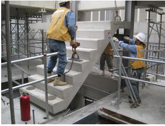
图 42 预制楼梯安装照片
