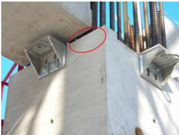
图 34 大梁安装依柱顶鸟嘴记号
