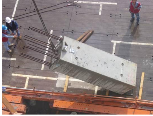
图 16 预制柱起吊前已锁好固定座
