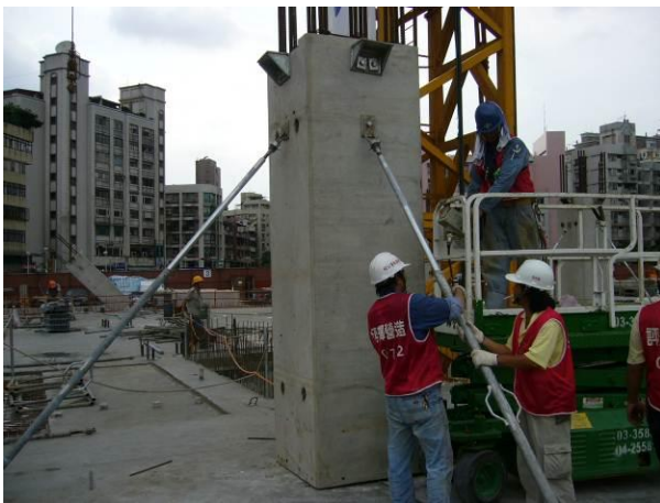
图 18 斜撑锁紧照片
