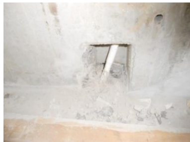
(b) 机电管线穿过部位堵漏
