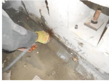
(b) 用压力水冲洗浆体
