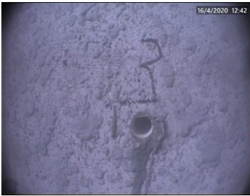
(a) 在出浆孔钻孔
