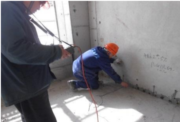
图 F.1 现场检测
