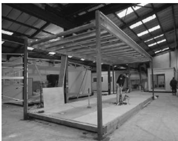
(2) 角柱支撑模块单元
